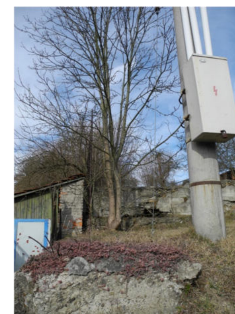
Část opěrné zdi, která drží svah od východu a sloup vysokého napětí
