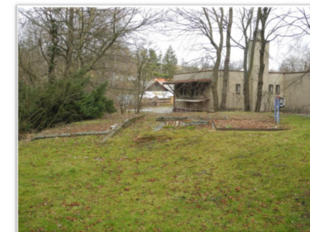
Rastr pěstebních ploch lemovaných betonovými obrubnicemi
