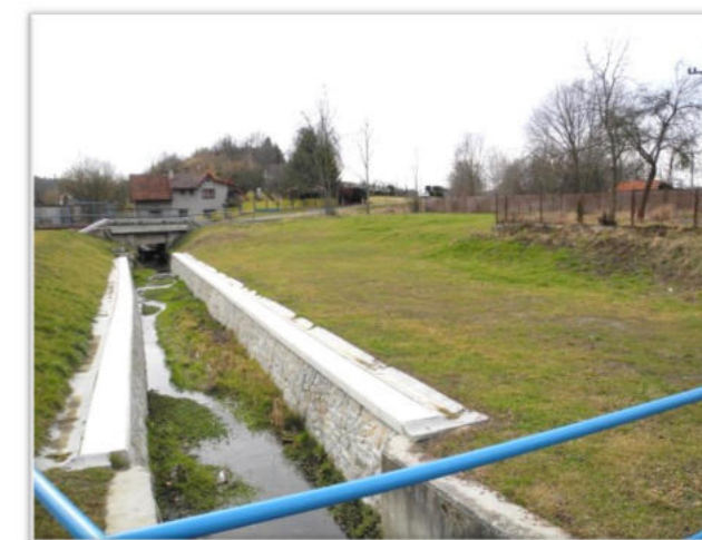
Pohled na vyzděné koryto potoka, který protéká plochou
