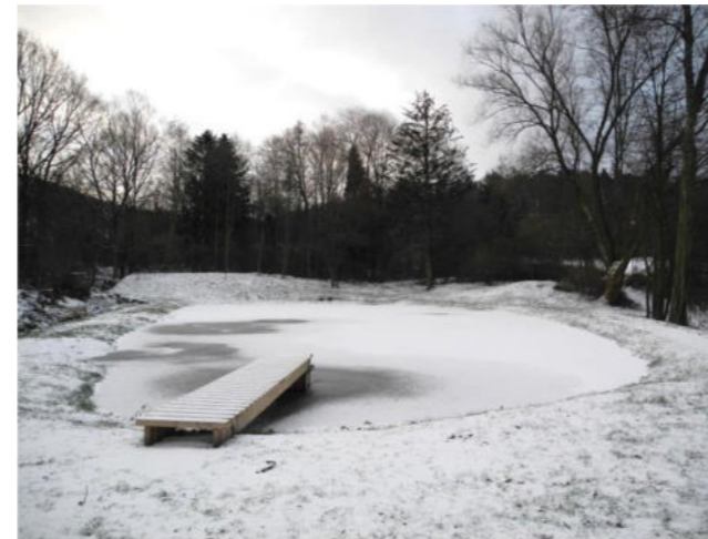
Retenční nádrž s dřevěným požerákem
