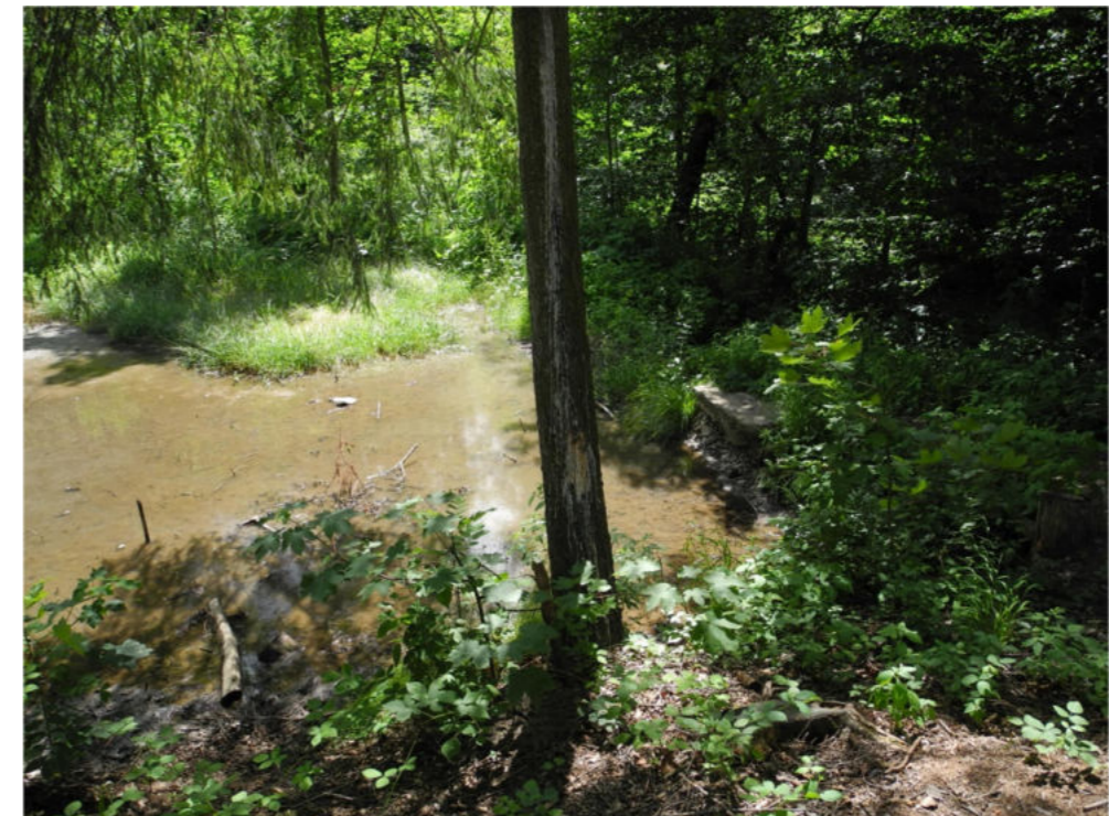
Pohled na poškozenou hráz
